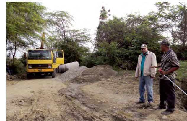
Costrucción de puentes drenaje, municipio Laguna Salada.
